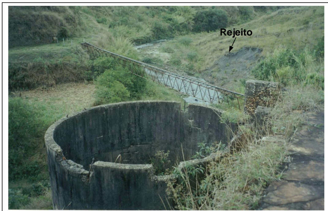
Fotografia 2 - Ruínas das instalações da Mina de Santa Efigênia, exibindo rejeito às margens do Ribeirão do Carmo.
